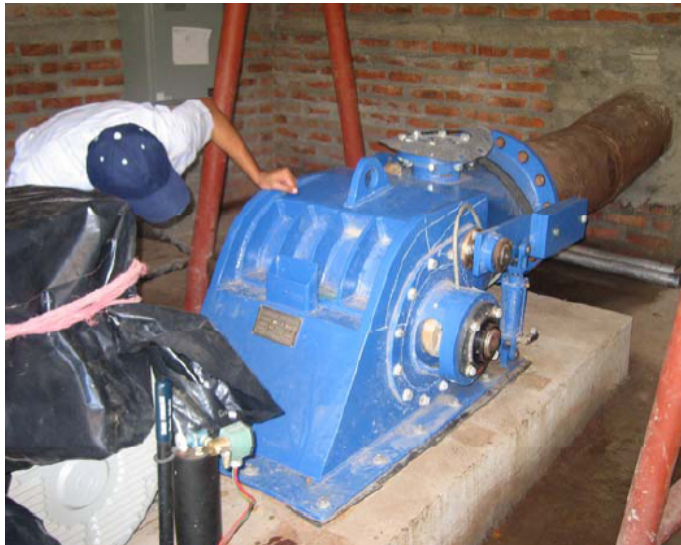
TURBINA BANKI DE 34 KW INSTALADA EN MIRACAPA
